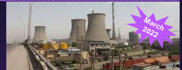
DVC Andal 500 MW
